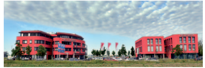
Links Haus A, rechts der Neubau (Haus B).
